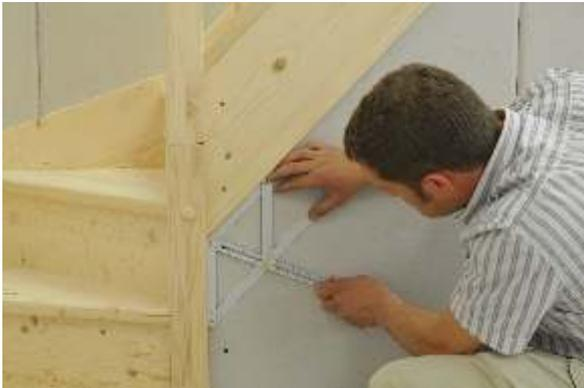
Die Winkelschmiege eignet sich zum analogen abnehmen und übertragen von Winkeln sowie zur Bestimmung von Gehrungen.
