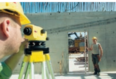
Hoch- und Tiefbau
