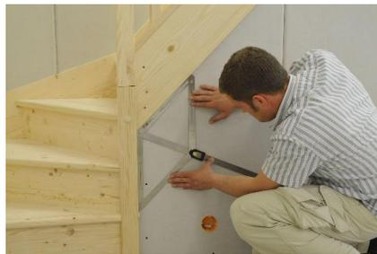
**Dépose et transfert d'angles**
