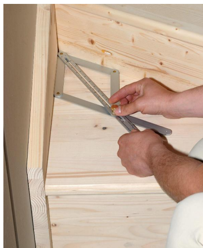
Remoção e transferência de ângulos
