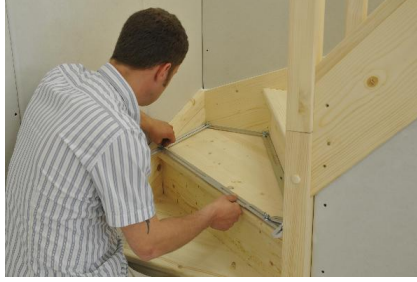
Farklı alüminyum raylara dayalı olarak neredeyse her türlü şekil oluşturulabilir
