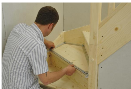
Grazie alle diverse guide in alluminio è possibile creare quasi ogni forma desiderata
