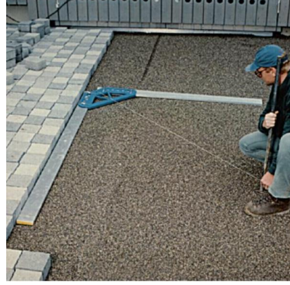
İki düzleştirme çubuğunu dik açıyla birleştirir
