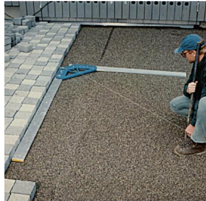
Verbindet zwei Richtlatten zu einem rechten Winkel
