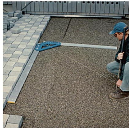
Verbindt twee richtlatten tot een rechte hoek
