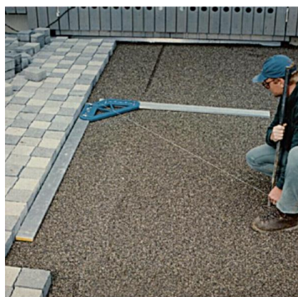
Liga duas réguas de nivelamento para formar um ângulo reto
