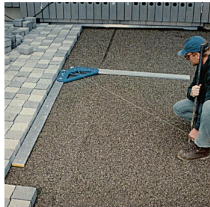
Verbindt twee richtlatten tot een rechte hoek
