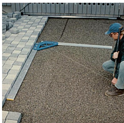
Conectează două rigle de zidărie pentru a forma un unghi drept
