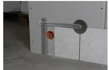
Einfaches Anreißen von Anschlussfliesen
