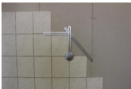
Ilustração de formas individuais em combinação com gabarito angular
