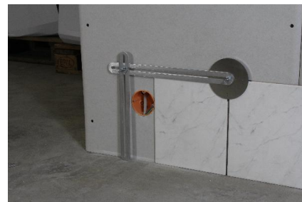
Marquage simple des dalles de raccordement
