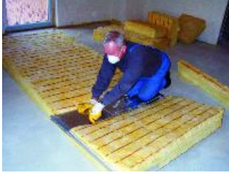
İzolasyon mastarının genişliği ve uzunluğu ayarlanabilir ve kesim sırasında vücut ağırlığı ile yüklenebilir.
