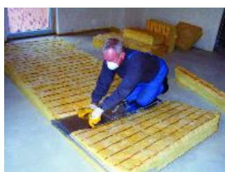
De isolatie mal is in breedte en lengte verstelbaar en kan tijdens het snijden met lichaamsgewicht worden belast.
