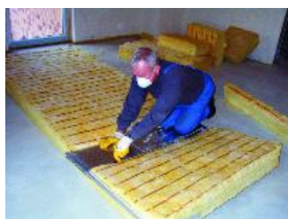
Szablon do materiałów izolacyjnych ma regulowaną szerokość i długość i może być obciążany ciężarem ciała podczas cięcia.
