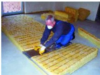
**A Medição de isolamento é ajustável em largura e comprimento e pode ser carregada com o peso do corpo durante o corte.**
