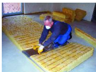
L'outil de traçage pour isolants est réglable en largeur et en longueur et peut être soumis au poids du corps lors de la découpe.
