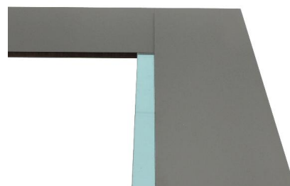
Schone en zichtbare ondersteuning door middel van plastic afstandhouders
