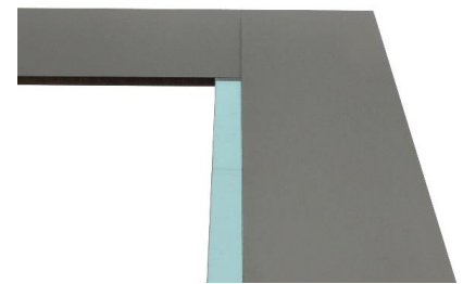
Czyste i widoczne podparcie poprzez plastikowe podkładki dystansowe
