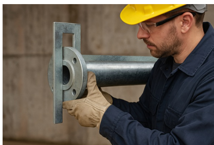
Exaktes Ausrichten von Flanschplatten am Rohrende.
