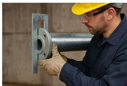
Exaktes Ausrichten von Flanschplatten am Rohrende.
