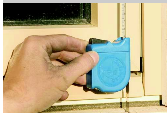
Pomiar szerokości od krawędzi zewnętrznej
