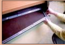
On mesure exactement et rapidement avec un outil approprié le profil de chacune des marches.
