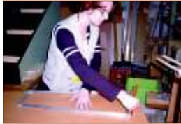
A l'aide du calibre, le report de forme sur la pièce à poser est extrêmement simple.
