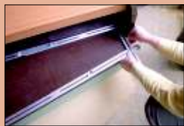
On mesure exactement et rapidement avec un outil approprié le profil de chacune des marches.
