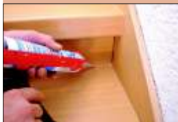
Lorsque les marches et les contremarches sont ajustées et collées, les jointures sont fixées avec un silicone coloré.
