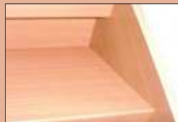
Une fine couche de silicone suffit pour faire disparaître les joints et le nouvel escalier apparaît dans toute sa beauté.
