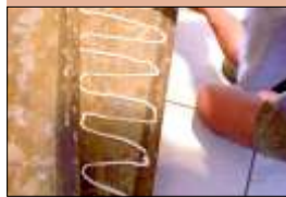
Pour la fixation une colle spéciale est appliquée en filets sur les anciens et les nouveaux degrés.
