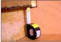
Puis la longueur, la largeur et l'angle à droite et à gauche des contremarches sont mesurés.
