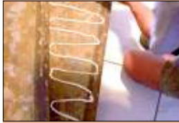
Pour la fixation une colle spéciale est appliquée en filets sur les anciens et les nouveaux degrés.
