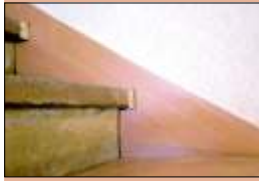
Le revêtement de limon est découpé dans du laminé ou du polyester puis collé.
