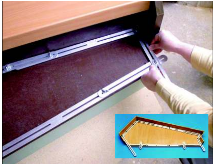
On mesure exactement et rapidement avec un outil approprié le profil de chacune des marches.
