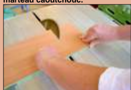
Etape par étape : les extrémités des contremarches sont découpés à 45°.
