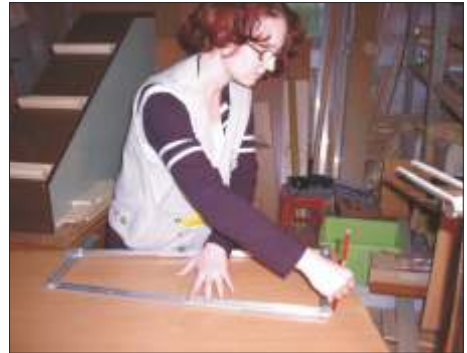
Mit der Winkelschablone wird die Form auf den neuen Belag oder eine Papierschablone übertragen.
